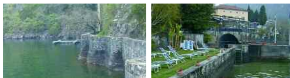
A sinistra, pontile e a destra muraglione del giardino dell'hotel Camin.
