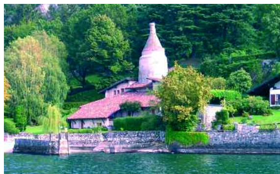
Darsena abbandonata vicino ad una vecchia fornace.
