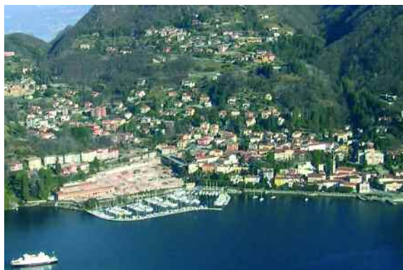
Panoramica del Portolabieno
